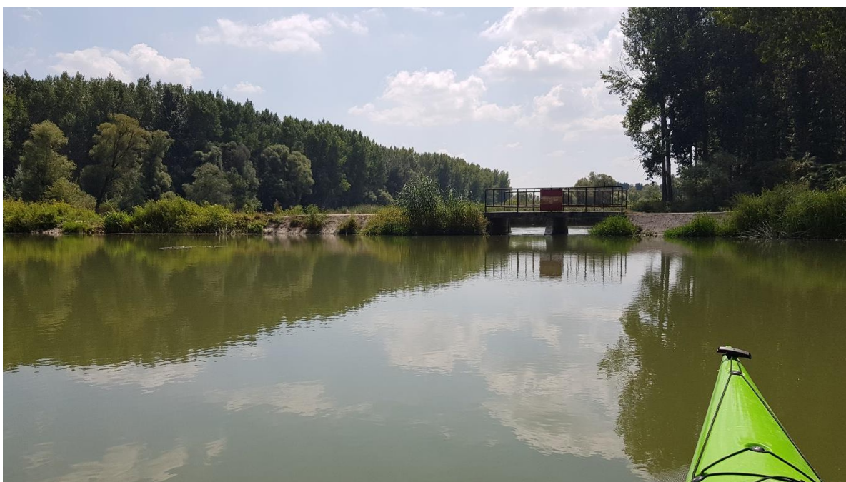
218. kép: Gatyai vízszintszabályozó műtárgy és híd (ÁS 5) a Gatyai-Duna északi oldalától.
