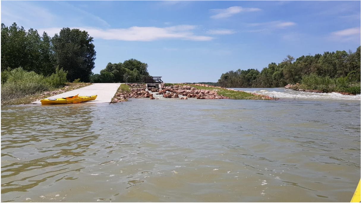
219. kép: Ásványi fenékküszöb és hallépcső (ÁS 30).
