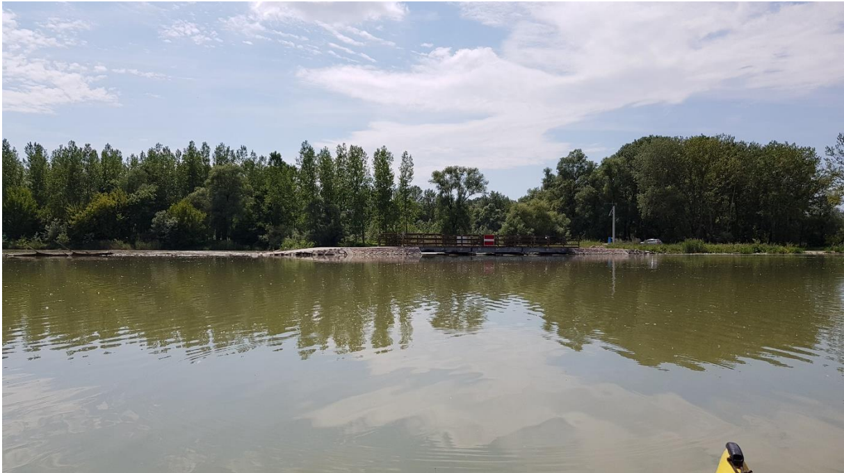
201. kép: Árvai vízszintszabályozó műtárgy (ÁS 4).
