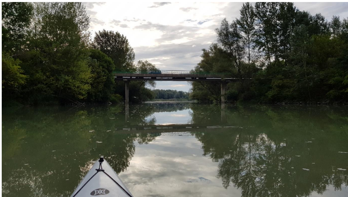
50. kép: Szivárgó csatorna híd (TE 19.2)
