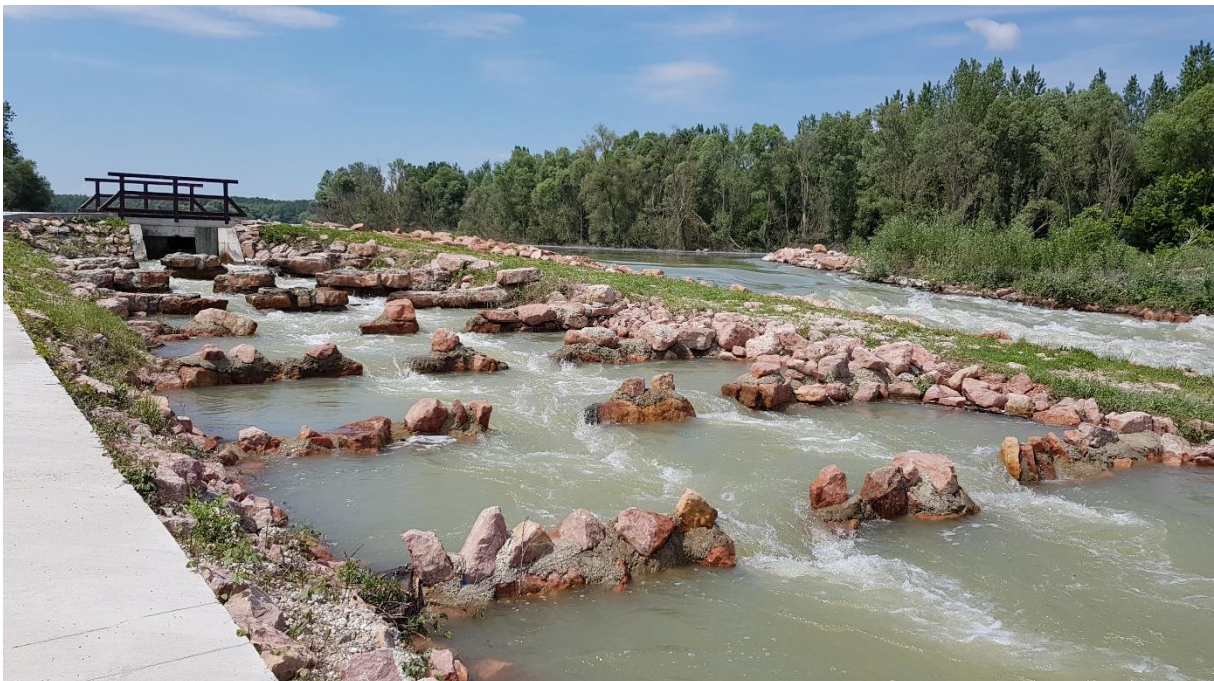
202. kép: Ásványi fenékküszöb és hallépcső (ÁS 30).
