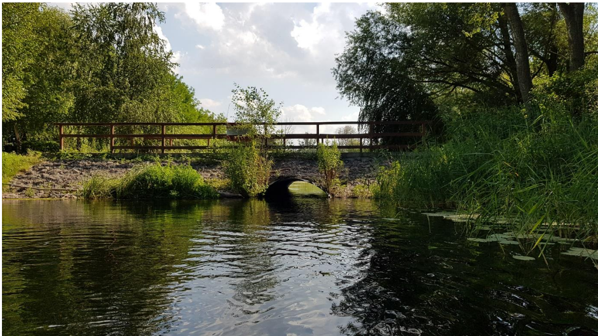
145. kép: Sragner áteresz a Zátonyi-Duna alsó szakaszán.
