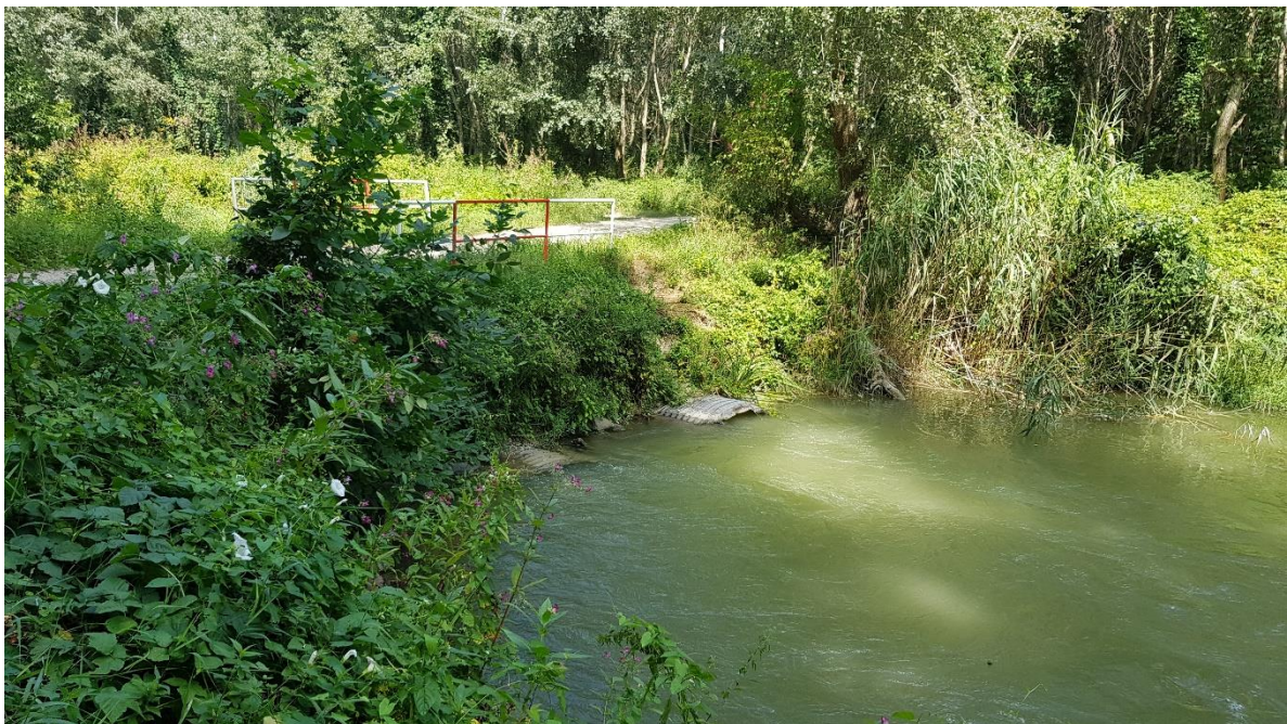
214. kép: Szilfási átereszt (ÁS 16) növényekkel benőtt nyílása.
